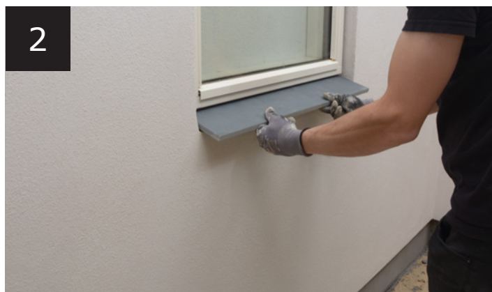
Montering af skifer-inddækning
