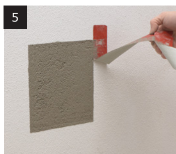
5 Afdækningstape fjernes
