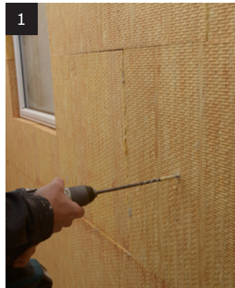
Udboring med 4-skærs murbor
