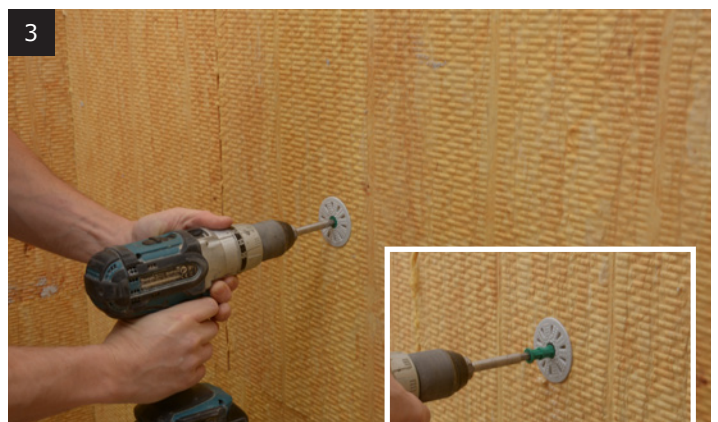
Montering af termodybel
