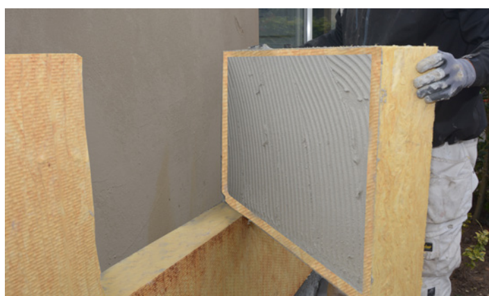
Montering på jævnt underlag
