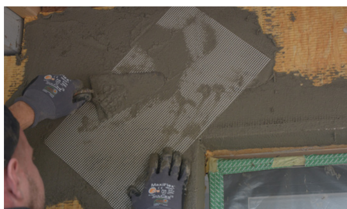
Ekstra forstærkning med stykker af armeringsnet
