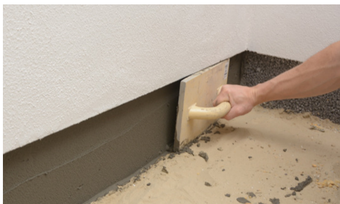
Bearbejdning med pudsebræt til jævn overflade
