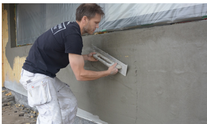
Træk grundpudsen på med stålbræt
