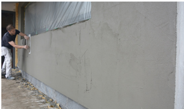
Efterglit med stålbræt
