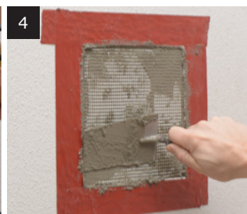
4 Grundpudslag og armeringsnet
