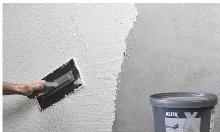
Overfladen bearbejdes med plast glittebræt
