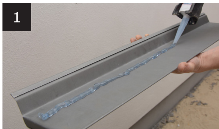
Påføring af Alfix M-Silicon
