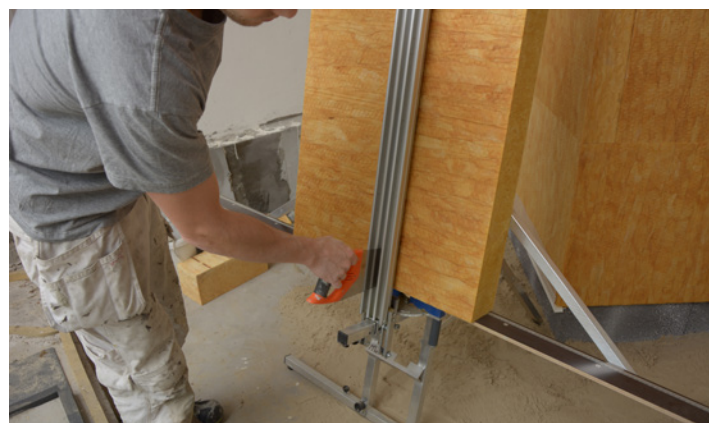
Tilskæring af isoleringsplade
