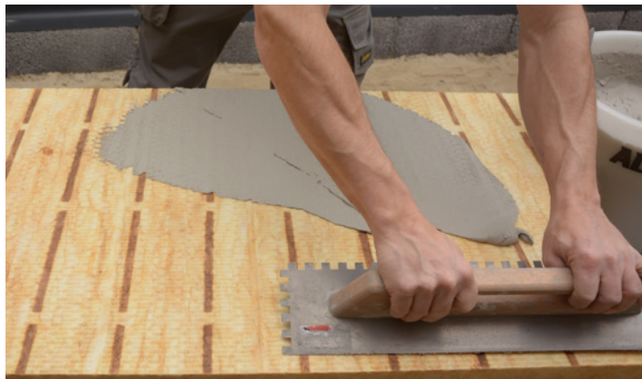
Påføring af facadeklæber med tandspartel
