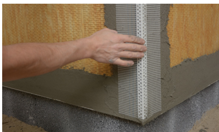
Placér hjørnelisten i den friskpåførte grundpuds
