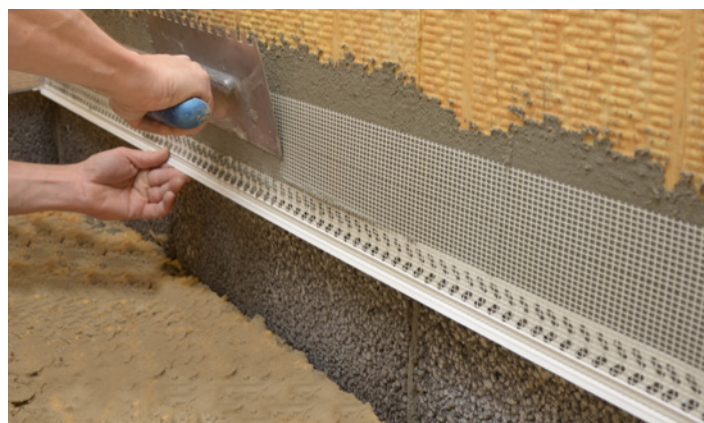
Bundlistens armeringsnet trykkes ind i grundpuds
