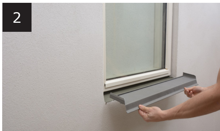
Montering af zink-inddækning
