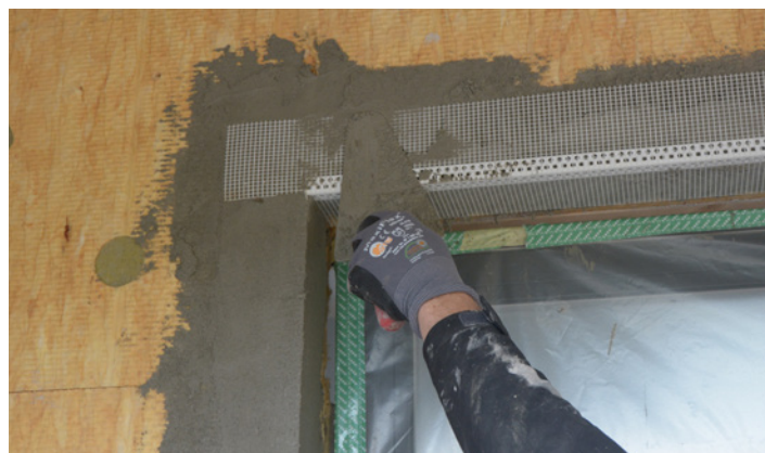
Montering af tilpasset hjørneliste i vinduesoverfals
