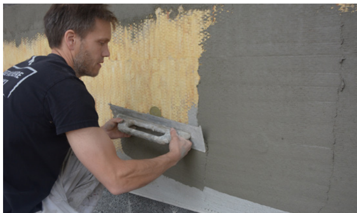
Påføring af grundpuds - Alfix DuraPuds 810
