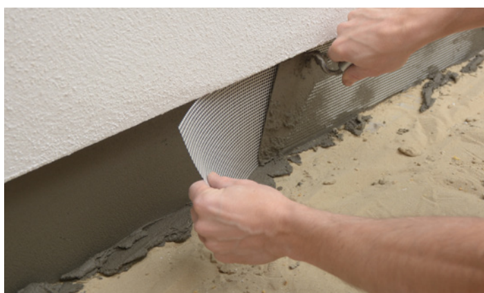
I den våde puds monteres armeringsnet
