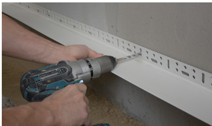
Forboring af hul til Alfix Startvinkel Flex
