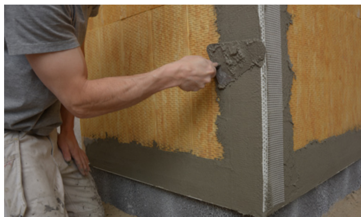
Hjørnelistens armeringsnet trykkes ind i grundpuds
