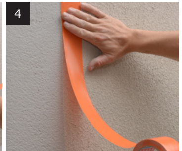
4 Monter ny tape når pudsen er tør
