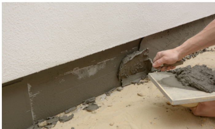
Dag 2 påføres andet pudslag i 3 - 4 mm
