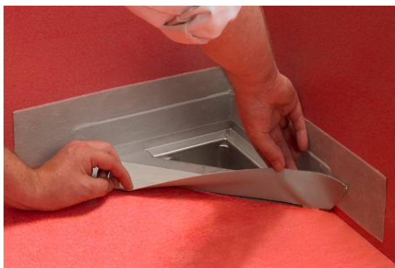
4a. Montering af Seal-Strip
