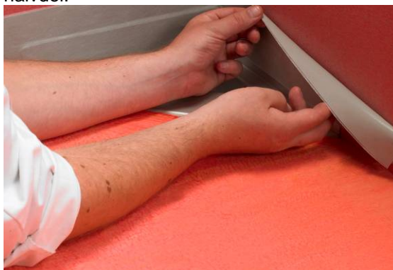
4. Montering af Seal-Strip
