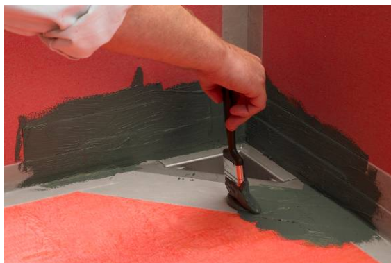
5. Påføring af Alfix Tætningsmasse
