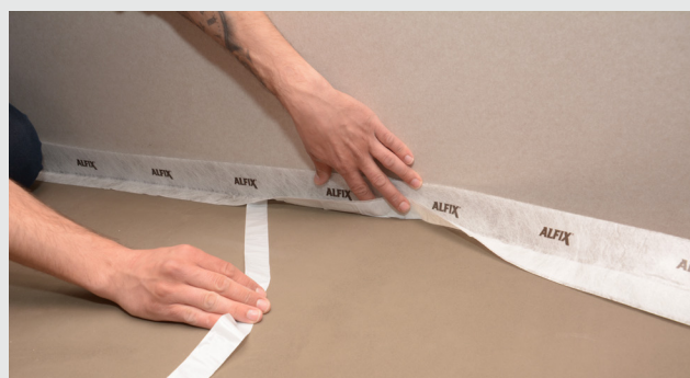
Montering av selvklebende veggkantbånd
