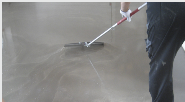
Fordeling av sparkelmassen
