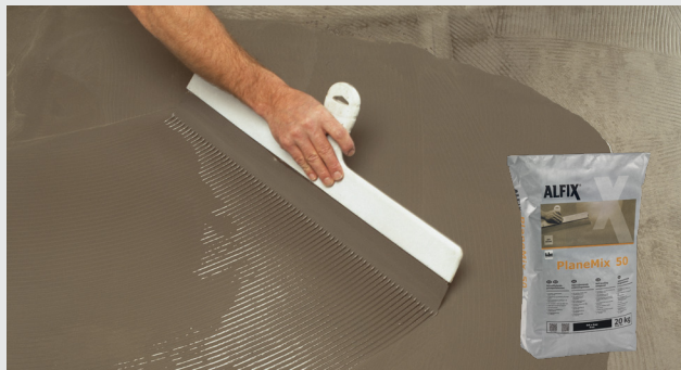
Fordeling av sparkelmasse
