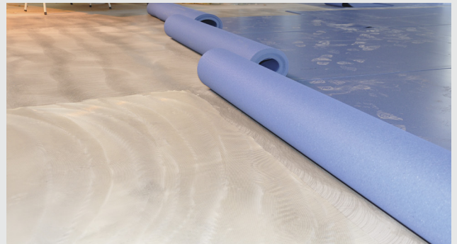
Montering av vinyl
