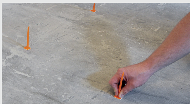
Markering med kotemål
