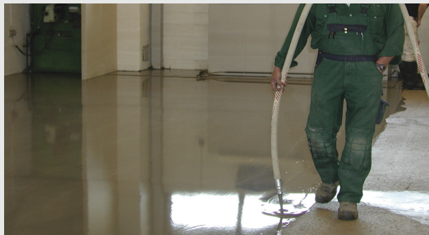
Utlegging med sparkelpumpe
