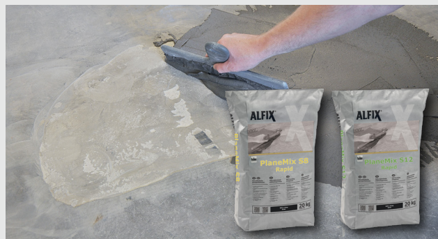
Sprekker og hulrom utbedres
