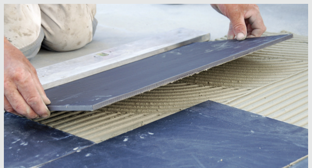
Montering av fliser
