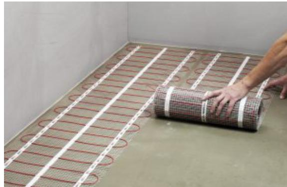
Varmematter, f.eks. Devimat, er selvklebende og utlegges direkte på det rengjorte og eventuelt primede underlaget.
