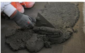
Alfix PlaneMix S40 brukes til oppretting og reparasjon fra 5 til 40 millimeter lagtykkelse på konstruksjoner der det stilles spesielt høye krav til både betongunderlag og pusslag.
