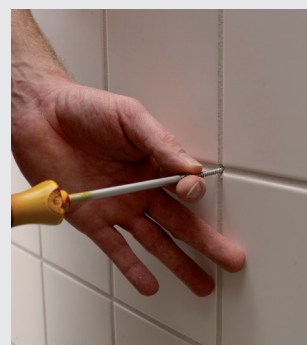
Montaż kołka plastikowego i śruby po wypełnieniu otworu preparatem M-Silicon
