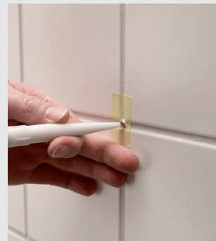
Wiercenie dziury i wypełnianie jej preparatem M-Silicon
