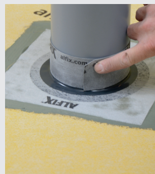
Wzmocnienie za pomocą taśmy Seal-Strip przy rurach obciążonych wodą
