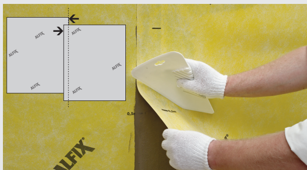
Montaż pasów na zakładkę na łączeniach
