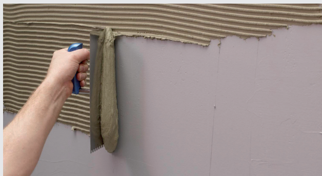
Nakładanie masy klejącej
