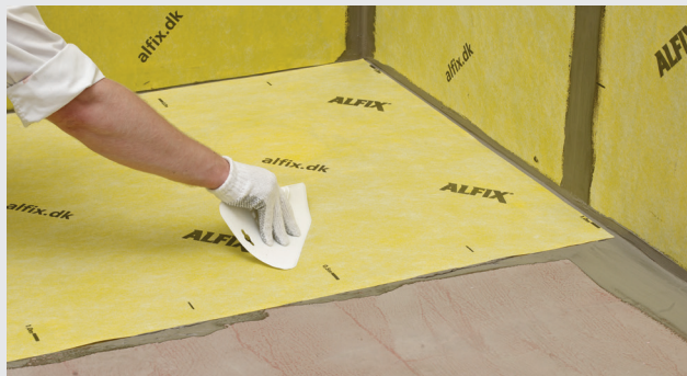
Montaż pasów na podłodze
