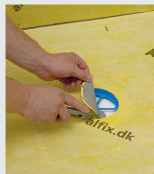
Wycinanie za pomocą szablonu przy mankiecie typu H
