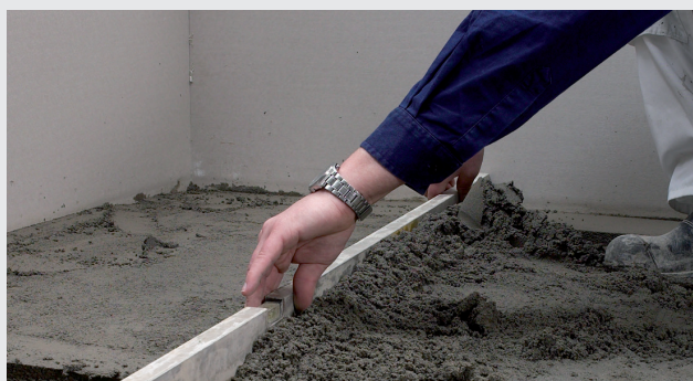
Wylewka na belkowaniu drewnianym
