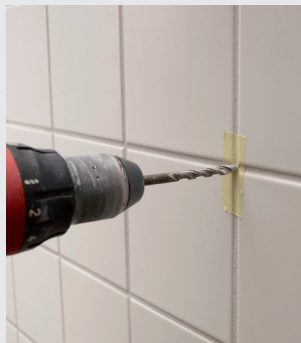
Wiercenie dziury i wypełnianie jej preparatem M-Silicon
