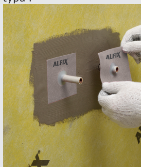
Montaż Mankietów rurowych VT
