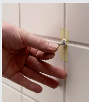
Montaż kołka plastikowego i śruby po wypełnieniu otworu preparatem M-Silicon
