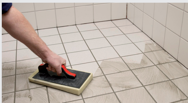
Czyszczenie za pomocą gąbki
