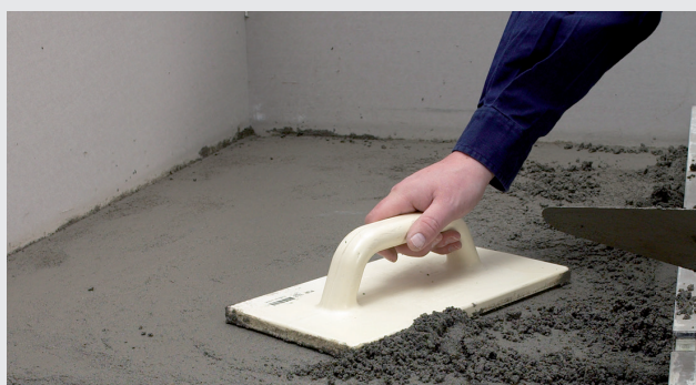
Wyrównywanie pacą murarską
