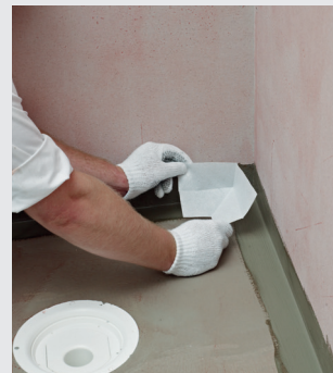
Wyrównanie nasiąkliwości Uszczelnienie w narożniku VT
