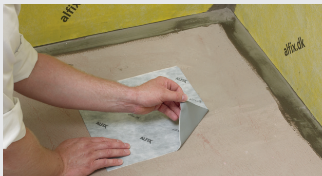
Montaż Mankietu Alfix do odpływu podłogowego
