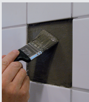
Na podłoże nałożyć masę uszczelniającą i przykleić płytkę.
