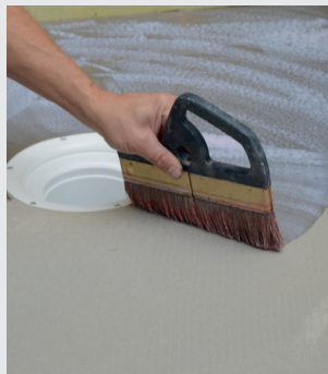
Wyrównanie nasiąkliwości Uszczelnienie w narożniku VT
