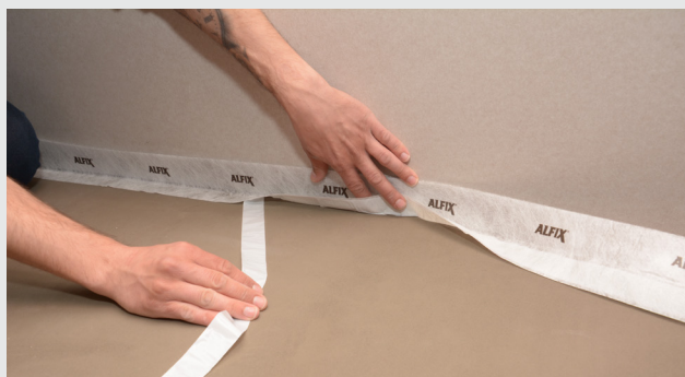
Montering av självhäftande väggkantband
