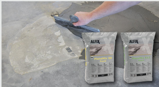
Sprickor och fördjupningar ifylls.
