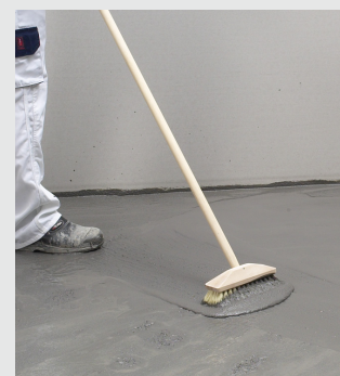
Slam/kvastning av golv
