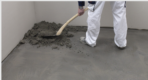
Cementbruk/slipsats fördelas jämnt
