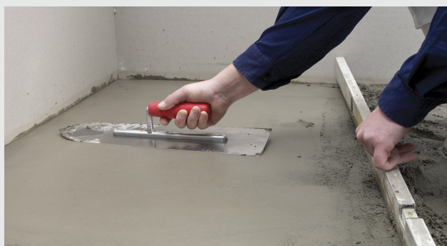
Cementbruk/slipsats glättas ut med spackel
