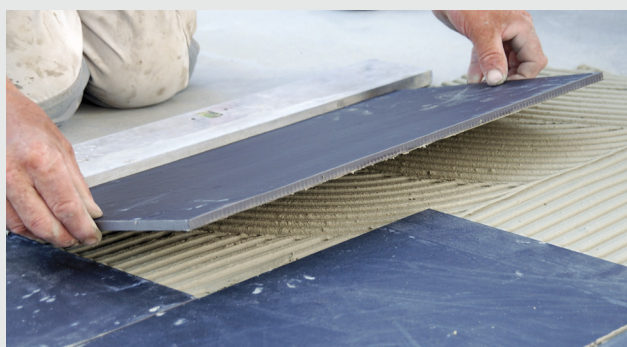
Montering av plattor
