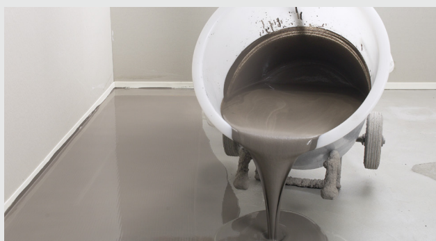
Spackelmasa hälls ut
