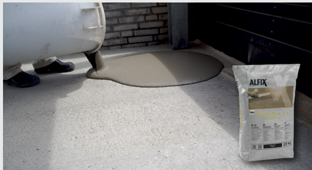
Självtjämnande spackelmassa hälls ut
