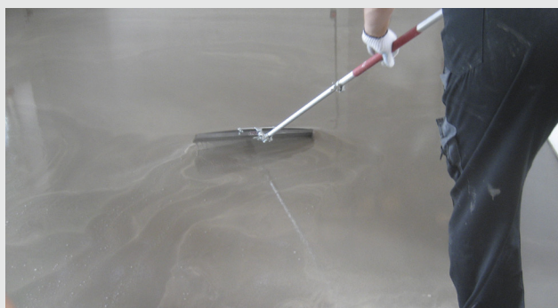
Fördelning av spackelmassan
