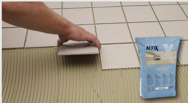
Plattläggning i Alfix fästmassor
