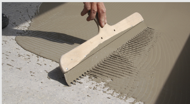
Fördelning med golvtandspackel
