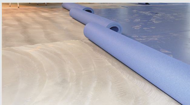
Montering av vinyl
