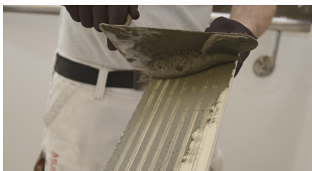
Påføring af skrabelag på flisens bagside
