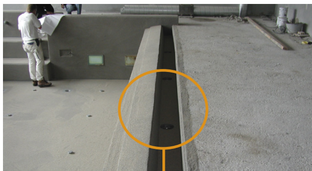
Montering af Alfix VT-Tætningsbånd
