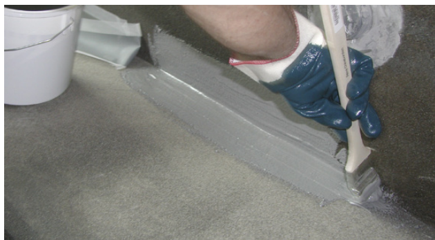
Påføring af Alfix Epoxy Membran
