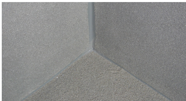
Ingen sanding i bevægelseszoner
