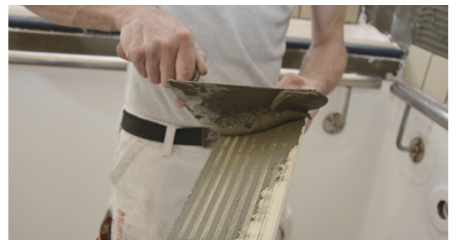
Påføring af skrabelag på flisens bagside
