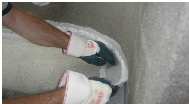
Montering af Alfix VT-Tætningsbånd
