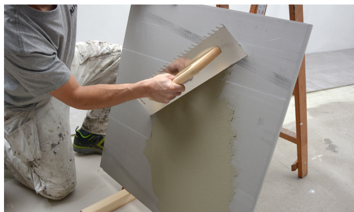
Applicering av fästmassa på plattans baksida (dubbellimning)
