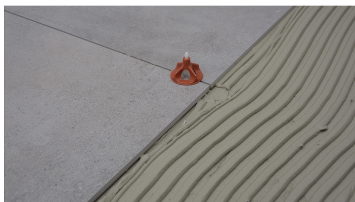
Exempel på nivelleringsystem för plattor
