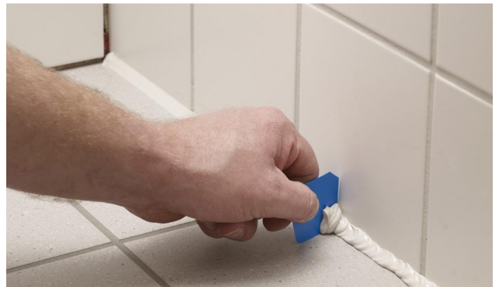
Överskjutande fogmassa skrapas bort
