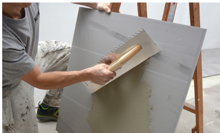
Applicering av fästmassa på plattans baksida (dubbellimning)
