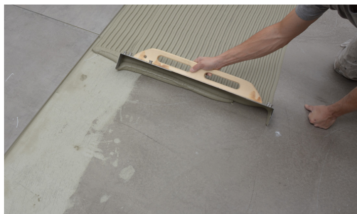
Applicering av fästmassa på underlag
