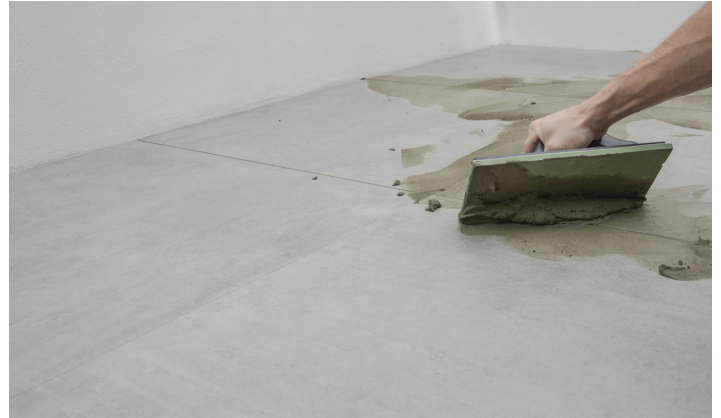
Påföring av fogmassa
