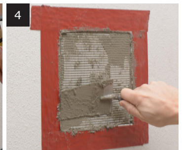
Grundpudslag og armeringsnet
