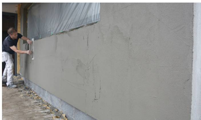
Efterglit med stålbræt
