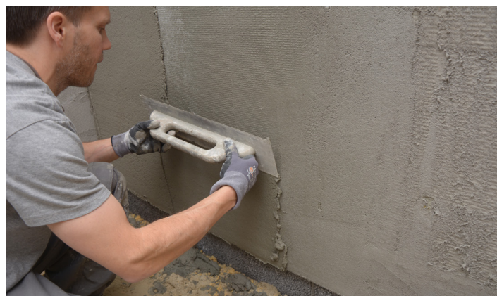
Påføring med stålbræt
