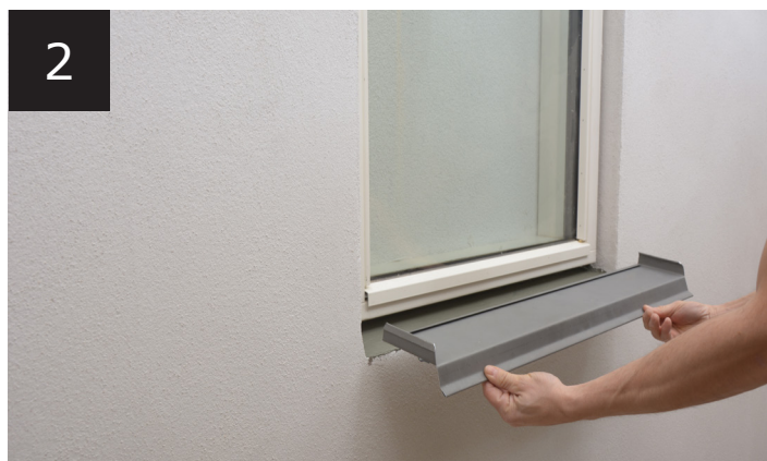
Montering af zink-inddækning
