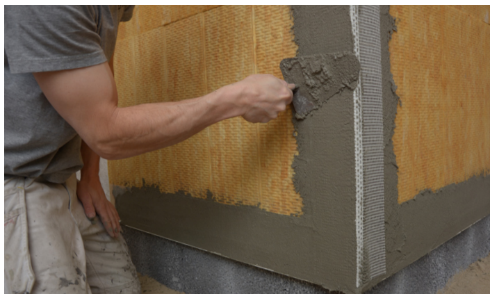
Hjørnelistens armeringsnet trykkes ind i grundpuds
