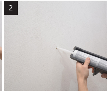
Ifyldning af Alfix M-Silicon
