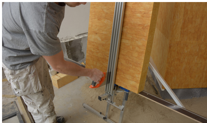
Tilskæring af isoleringsplade
