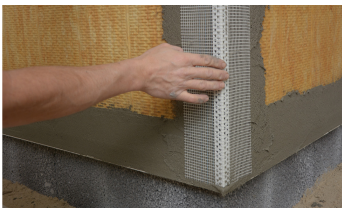
Placér hjørnelisten i den friskpåførte grundpuds
