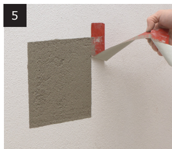
Afdækningstape fjernes
