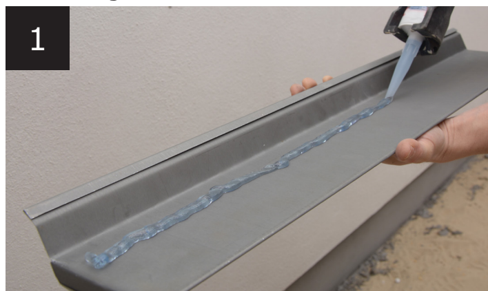
Påføring af Alfix M-Silicon
