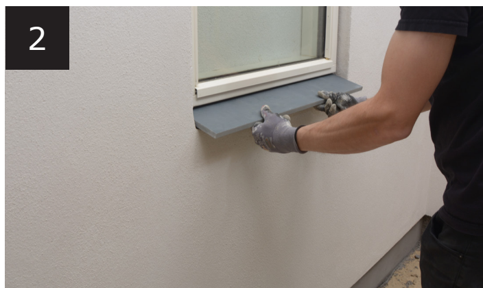
Montering af skifer-inddækning
