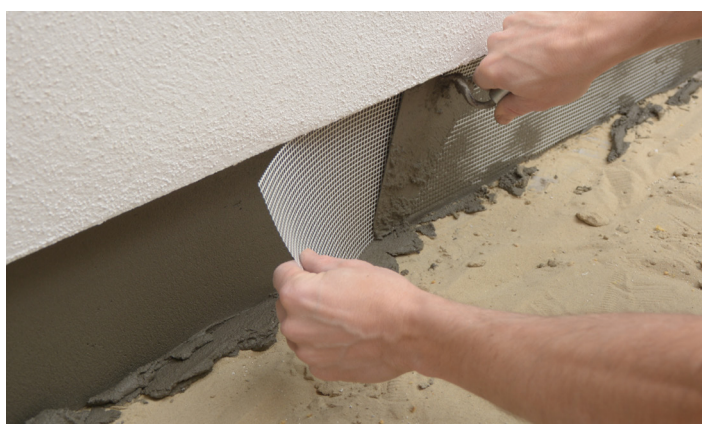
I den våde puds monteres armeringsnet
