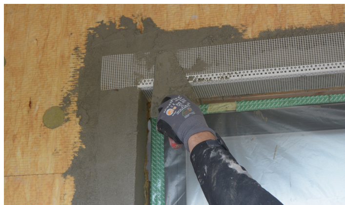
Montering af tilpasset hjørneliste i vinduesoverfals
