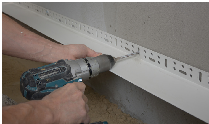
Forboring af hul til Alfix Startvinkel Flex
