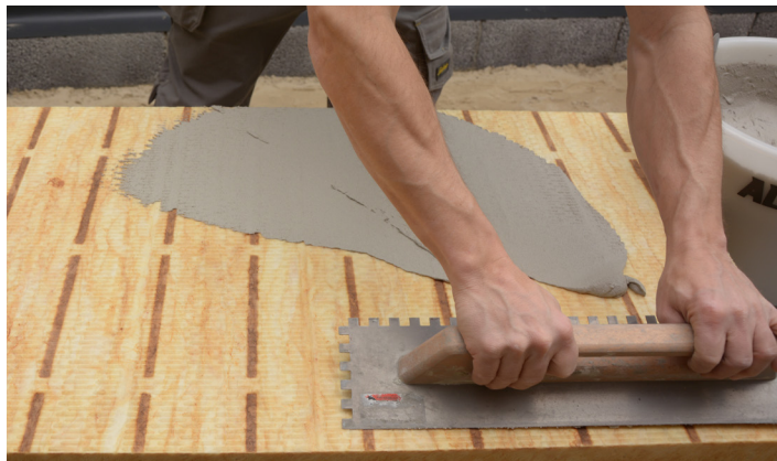
Påføring af facadeklæber med tandspartel
