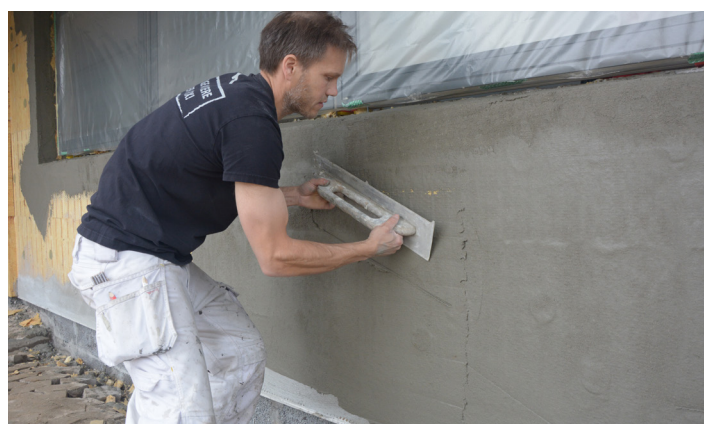
Træk grundpudsen på med stålbræt
