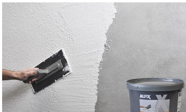
Overfladen bearbejdes med plast glittebræt
