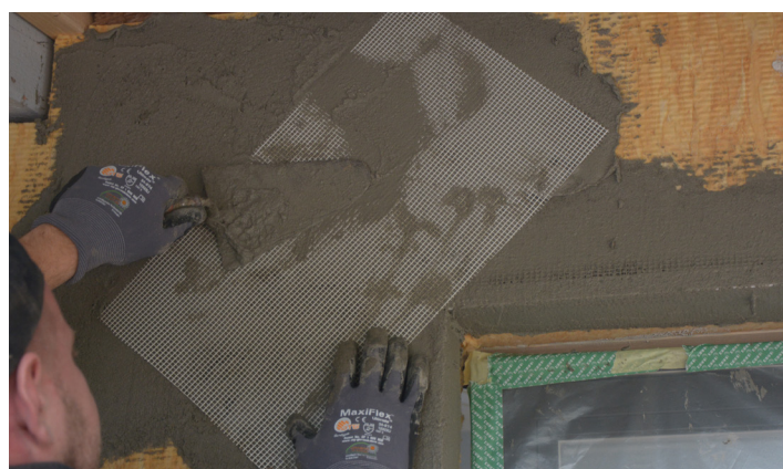
Ekstra forstærkning med stykker af armeringsnet
