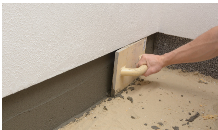
Bearbejdning med pudsebræt til jævn overflade
