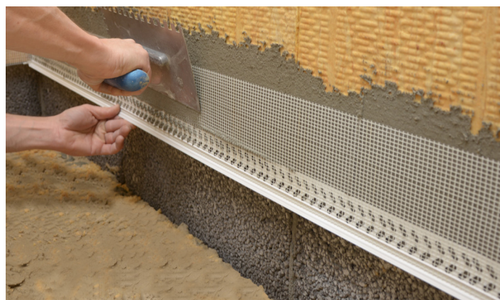
Bundlistens armeringsnet trykkes ind i grundpuds
