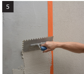
Påfør puds langs tapekant
