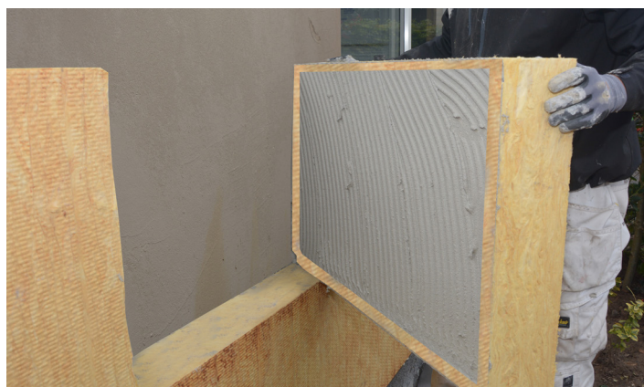
Montering på jævnt underlag
