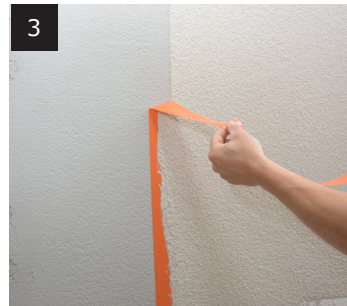
Tape fjernes umiddelbart efter udførelse
