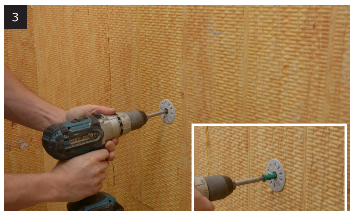
Montering af termodybel
