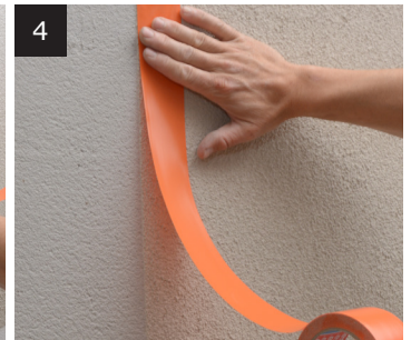
Monter ny tape når pudsen er tør
