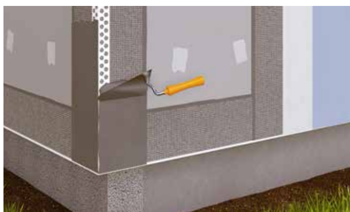
Placér hjørnelisten i den friskpåførte armeringspuds
