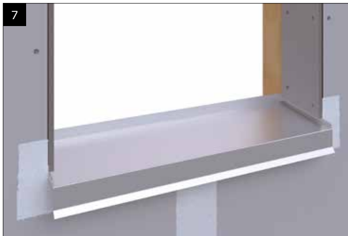
Lodrette false beklædes med tilpasset pudsbærende facadeplade. (Tømrer)
