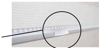
Eksempler på tildannelse af Alfix Uni-liste ved udvendige og indvendige hjørner
