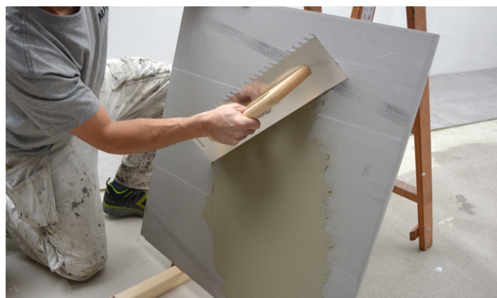
Fliseklæber påføres bagsiden af flisen (bagsmøring)
