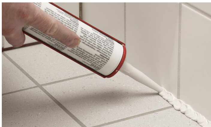
Påføring af silikonefugemasse
