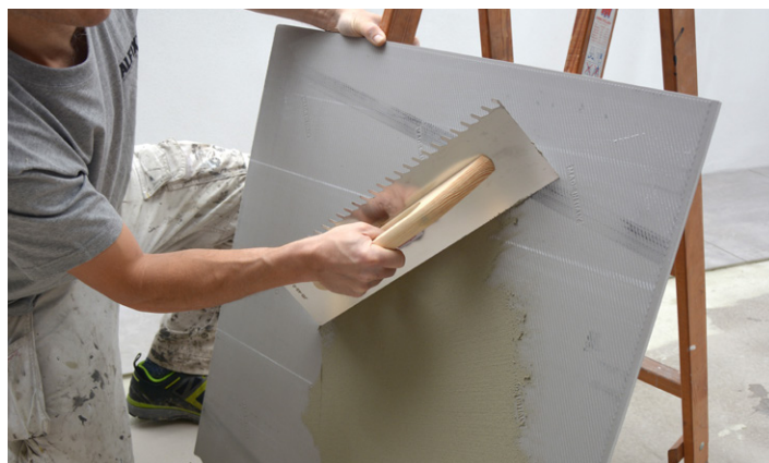
Påføring af fliseklæber på flisens bagside
