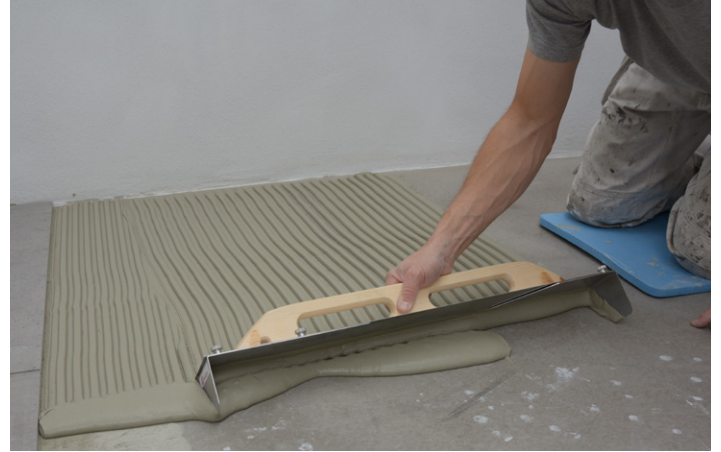
Påføring af fliseklæber på underlaget
