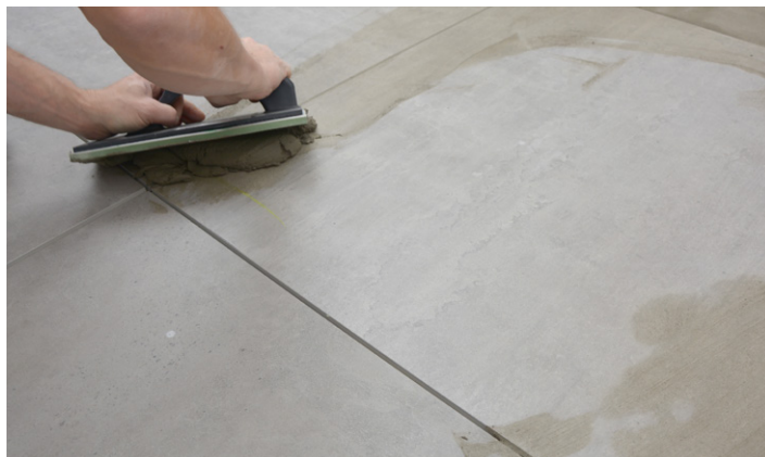
Påføring af fugemasse
