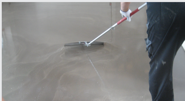
Fordeling av sparkelmassen
