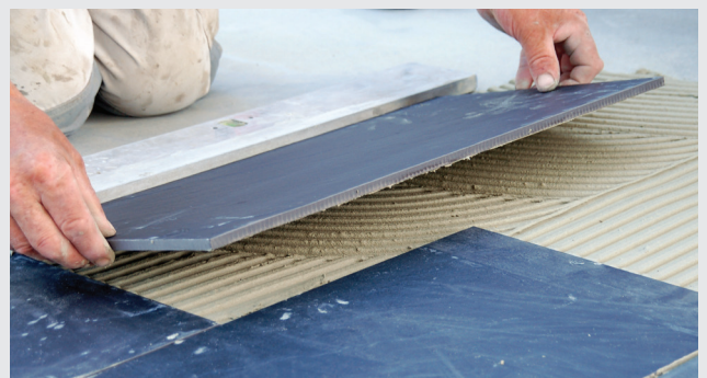
Montering av fliser
