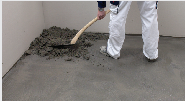
Støpemasse fordeles jevnt
