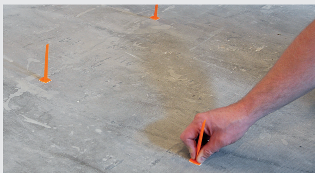
Markering med kotemål
