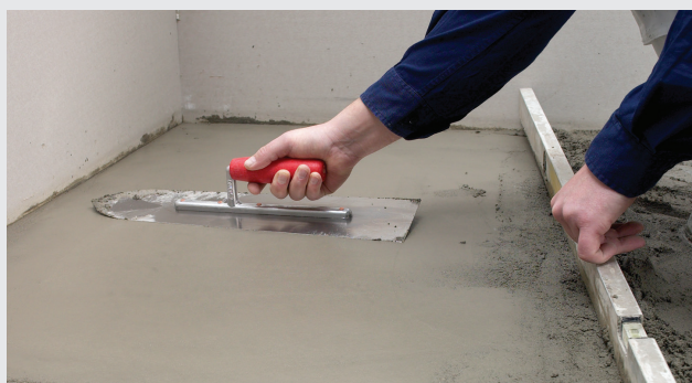
Støpemasse glattes ut med sparkel
