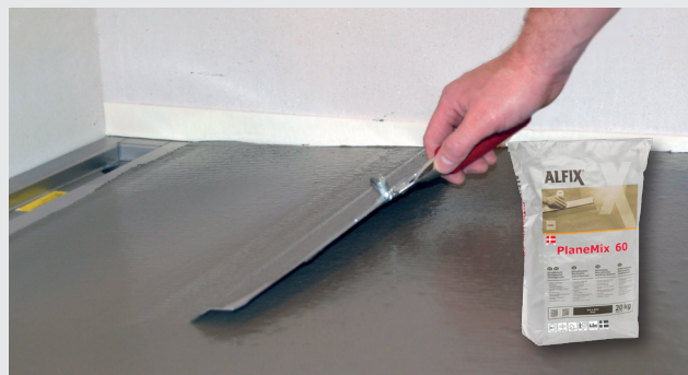
Fallopbygging ved designsluk
