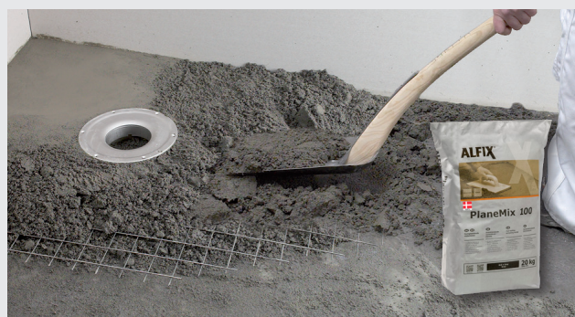
Oppbygging av fall med støpemasse
