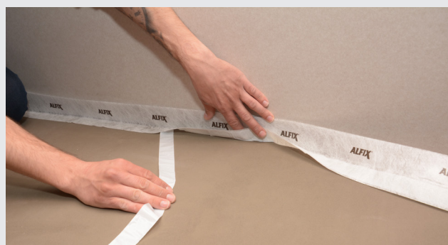
Montering av selvklebende veggkantbånd
