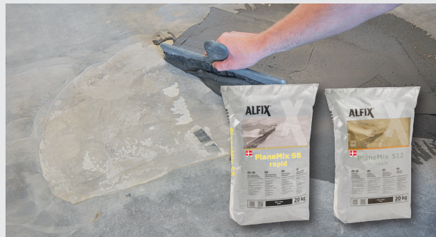
Sprekker og hulrom utbedres
