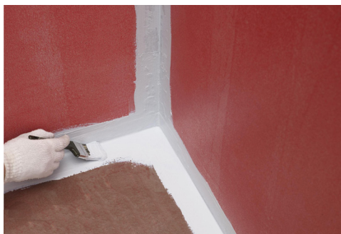
Påføring af Alfix Tetningsmasse
