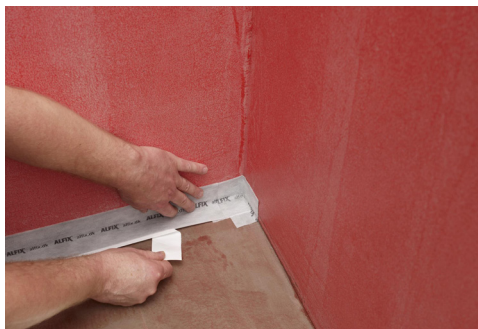
Tetning ved lodrette hjørner og overgang vegg/gulv
