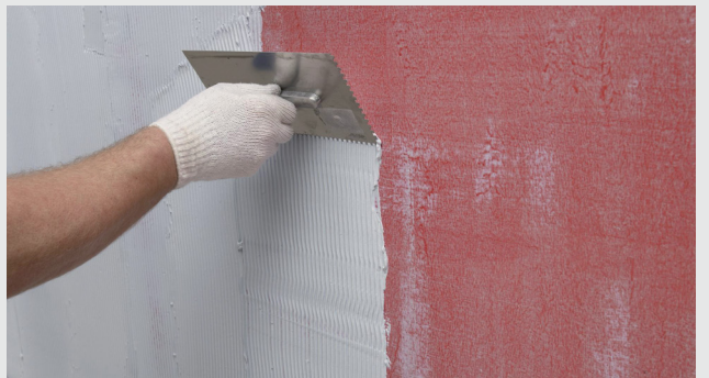
Påföring med tandspackel
