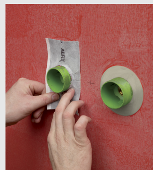
Montering av Seal-Strip, självhäftande
