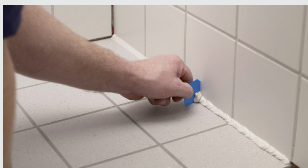
Överskjutande fogmassa skrapas bort
