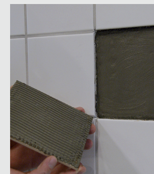
Tätningsmassan påförs underlaget och plattan monteras
