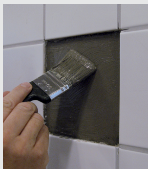
Tätningsmassan påförs underlaget och plattan monteras
