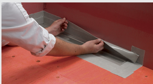
Montering av Seal-Strip vid väggnära golvbrunn
