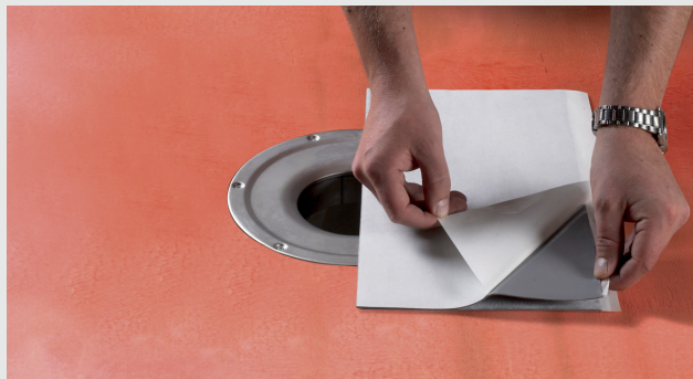
Montering av brunnsmanschett vid rund golvbrunn
