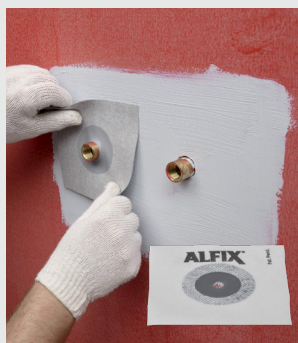
Montering av rörmanschett i 1K eller 2K Tätningsmassa
