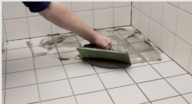
Påföring av fogmassa
