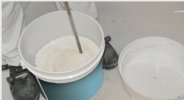
Mieszanie masy uszczelniającej
