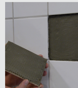
Na podłoże nałożyć masę uszczelniającą i przykleić płytkę.
