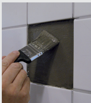
Na podłoże nałożyć masę uszczelniającą i przykleić płytkę.
