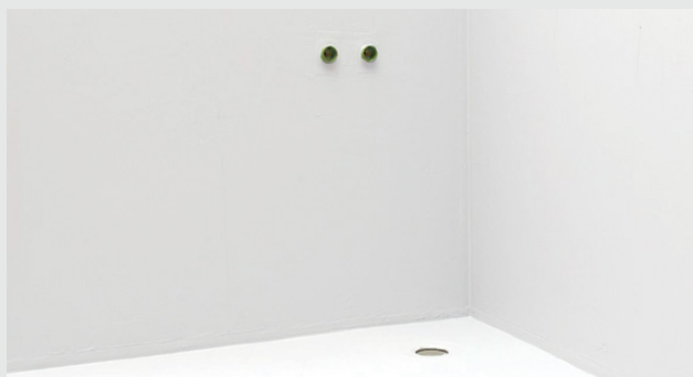
Pomieszczenie gotowe do ułożenia płytek
