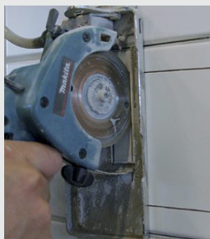
Wyciąć rowek wzdłuż krawędzi płytki. Ostrożnie wyjąć płytkę.
