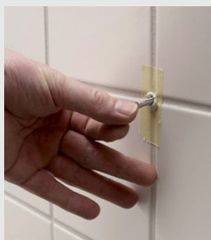
Montaż kołka plastikowego i śruby po wypełnieniu otworu silikonem M-Silicon
