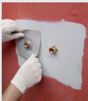
Montaż mankietu rurowego w masie uszczelniającej
