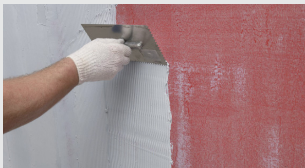
Nakładanie szpachlą zębatą
