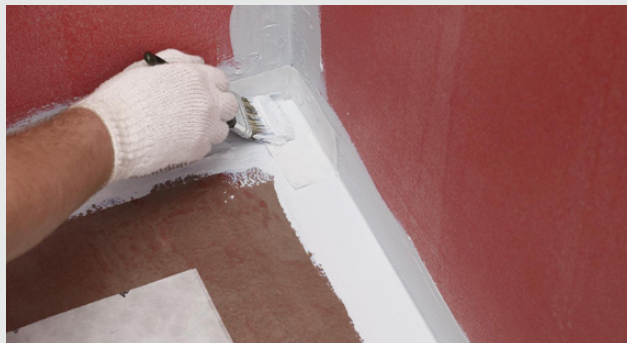
Przyklejanie taśmy zbrojącej przy użyciu masy uszczelniającej
