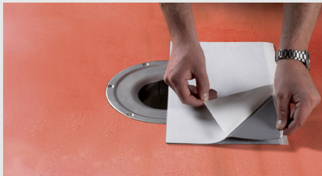
Montaż mankietu odpływu w przypadku okrągłego odpływu podłogowego
