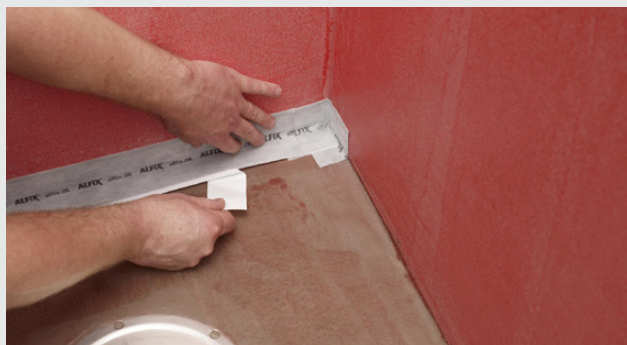
Montaż samoprzylepnej taśmy Seal-Strip
