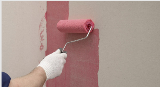
Nakładanie Impregnatu w płynie Alfix Vattenspärr na ścianę za pomocą wałka
