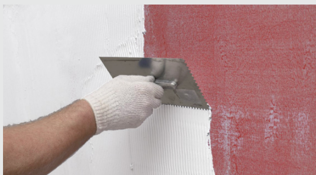
Nakładanie pacą zębatą...
