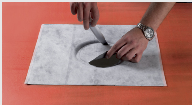
Wycięcie otworu nożem lub specjalnym narzędziem
