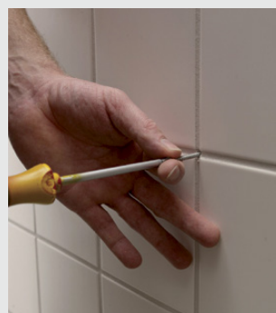
Montaż kołka plastikowego i śruby po wypełnieniu otworu silikonem M-Silicon
