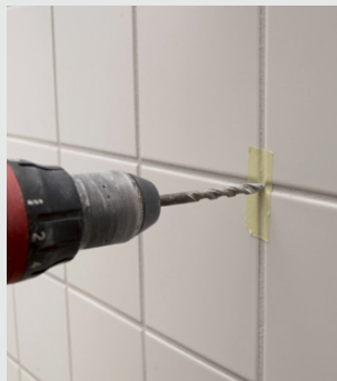
Wiercenie dziury i wypełnianie jej silikonem M-Silicon
