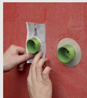
Montaż samoprzylepnej taśmy Seal-Strip
