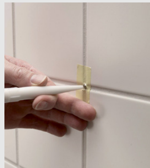
Wiercenie dziury i wypełnianie jej silikonem M-Silicon
