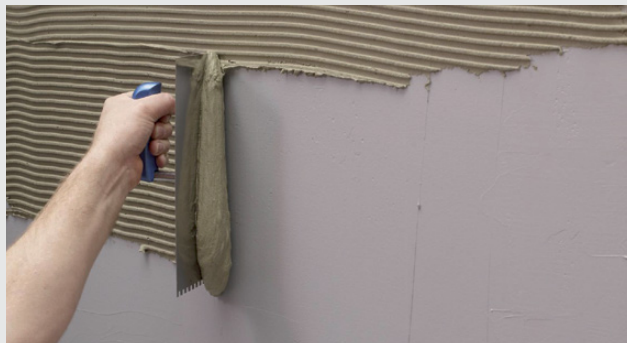
Nakładanie masy klejącej
