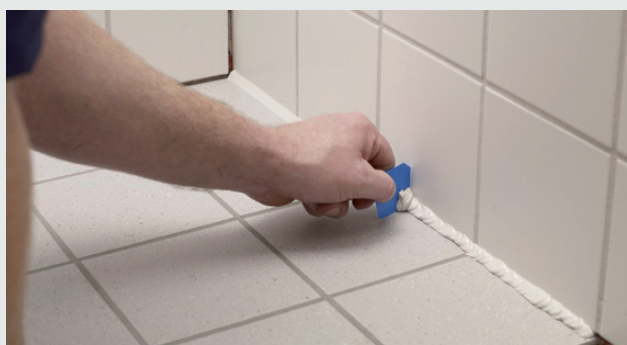
Nadmiar masy fugowej usunąć.
