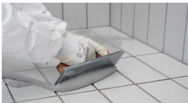
Ifyllning på golv med epoxifogbräda
