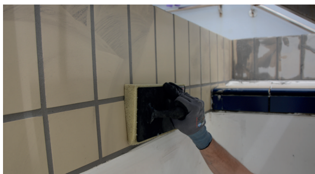
Plattorna jämnas och tvättas med en hårt urvriden viskossvamp
