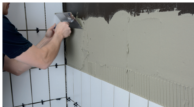
Applicering av fästmassa med tandspackel
