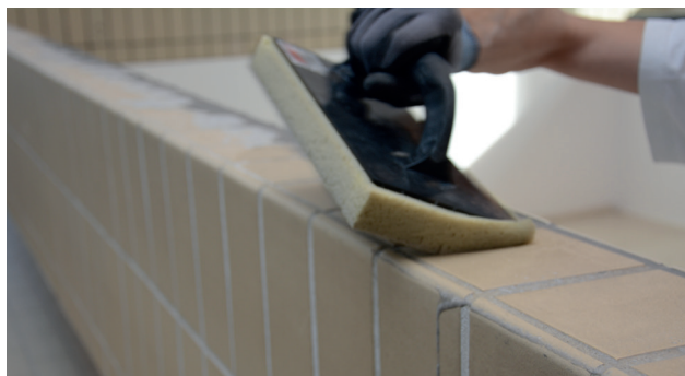
Fogarna anpassas efter plattornas utformning
