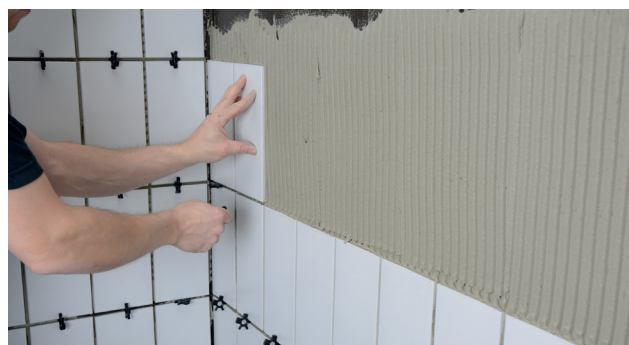
Montering av plattor
