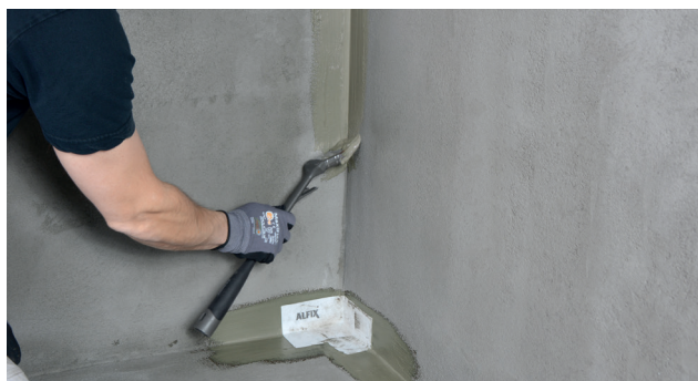
Montering av Alfix VT-hörn i tätningsmassa
