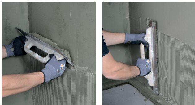
Applicering av 2K Tätningsmassa och glättning
