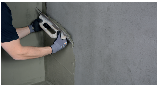
Applicering av Alfix 2K Tätningsmassa – porfyllande skikt
