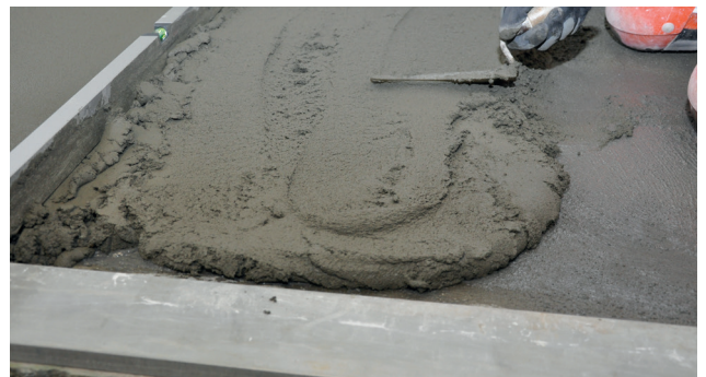
Utläggning och komprimering på golv
