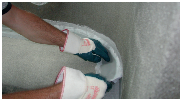
Montering av Alfex Tättningsband
