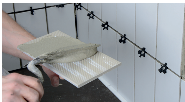
Dubbellimning (buttering/floating metoden)
