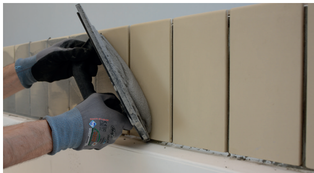
Ifylling av Alfix IndustryFuge - CeraFill 18
