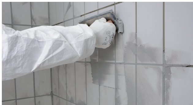
Ifyllning på vägg med epoxifogbräda
