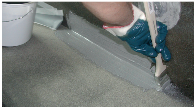
Applicering av Alfex Epoxy Membran
