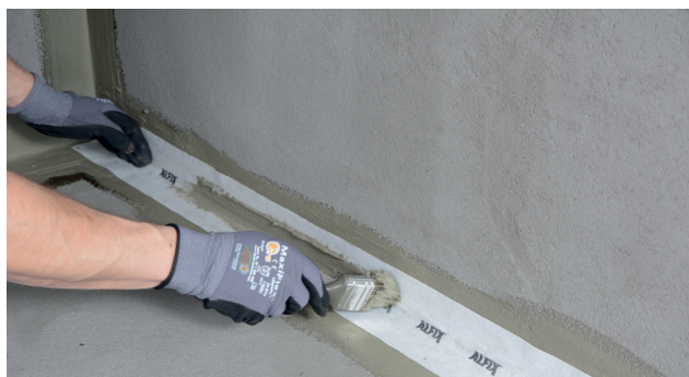
Montering av Alfix VT-tätningsband
