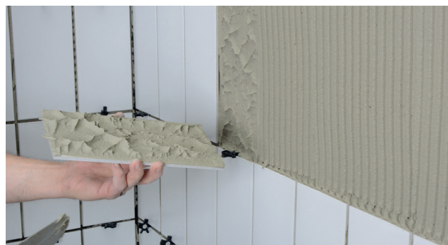
Kontroll av fästmassans täckning
