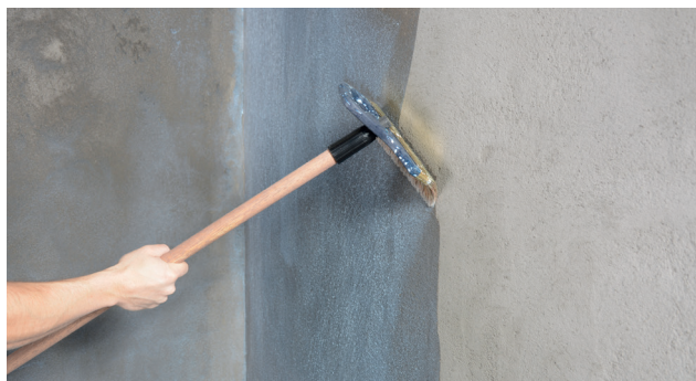
Primerbehandling med Alfix PlaneMixPrime
