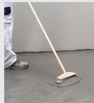
Slam/kvastning av golv
