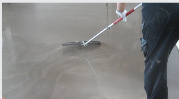
Fördelning av spackelmassan
