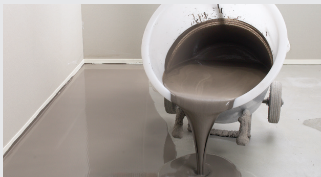
Spackelmasa hälls ut
