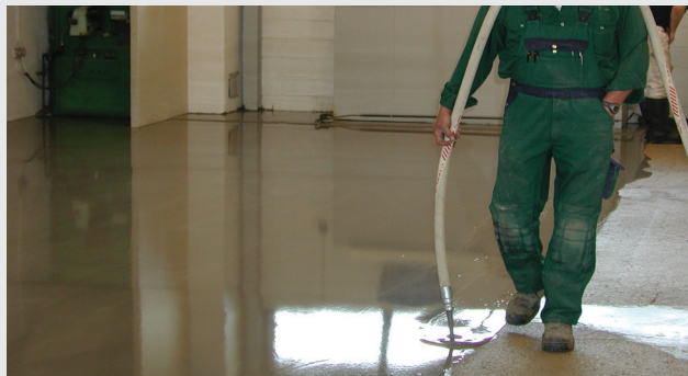
Planspackling med spackelpump
