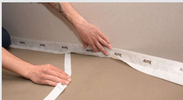
Montering av självhäftande väggkantband
