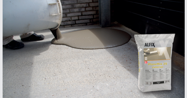
Självtjämnande spackelmassa hälls ut
