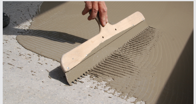
Fördelning med golvtandspackel
