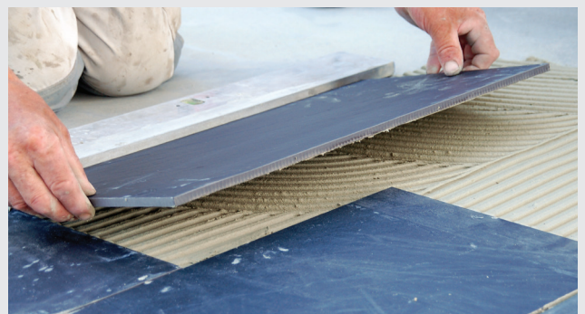
Montering av plattor
