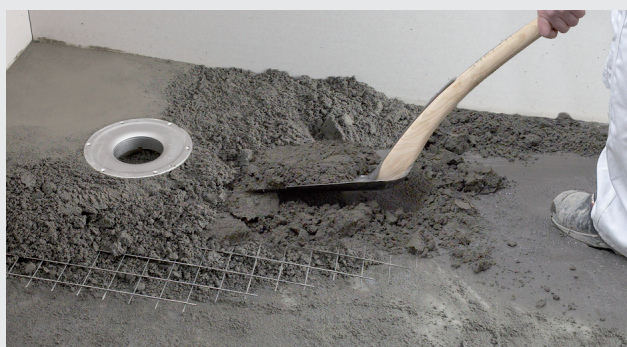
Uppbyggnad av fall med cementbruk/slipsats
