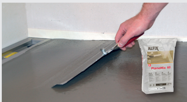
Fallupbyggnad vid designbrunn
