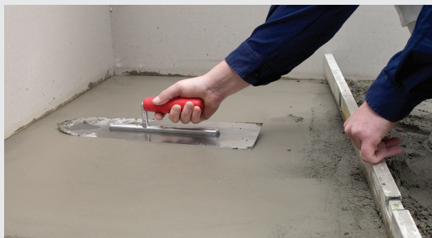
Cementbruk/slipsats glättas ut med spackel
