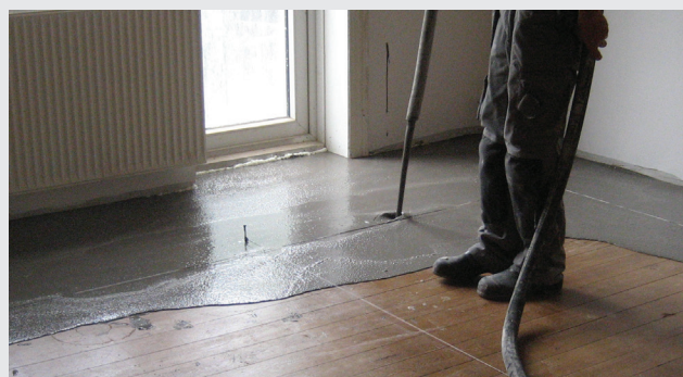
Spackling på träbjälklag
