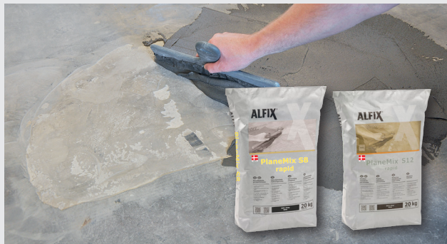
Sprickor och fördjupningar ifylls.
