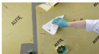
Montering av Alfix Våtrumsmatta
