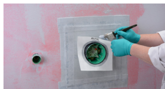
Montering af Alfix PU rörmanchett
