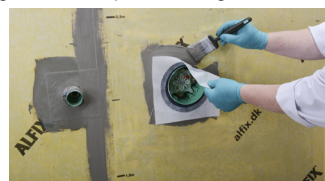
Montering av Alfix PU rörmanchett
