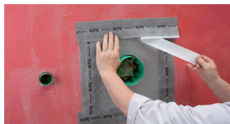
Försegling med Alfix Seal-Strip
