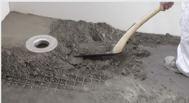
Golvlutning med cementbruk
