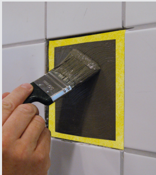
Tätningsmassan påförs underlaget och plattan monteras
