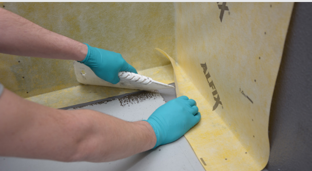
Montering av våtrumsmattan
