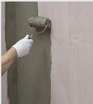
Påföring av tätningsmassa
