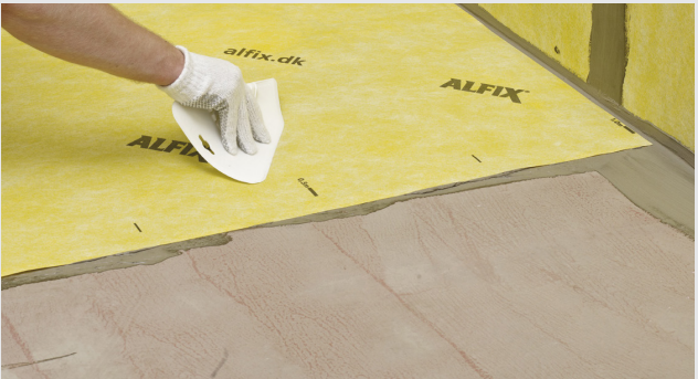
Montering av våd på golv
