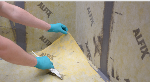
Montering av våtrumsmatta på golv
