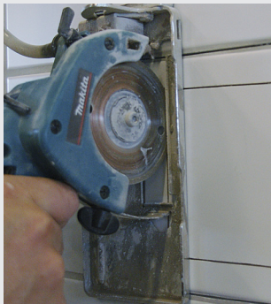
Skär ett spår längs plattkanterna. Avlägsna plattan försiktigt
