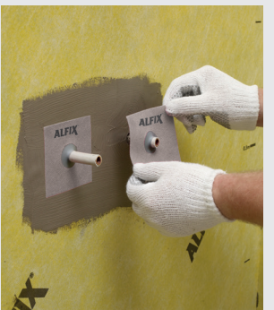
Montering av VT-Rörmanschetter
