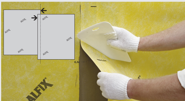
Montering av våd omlott vid skarv
