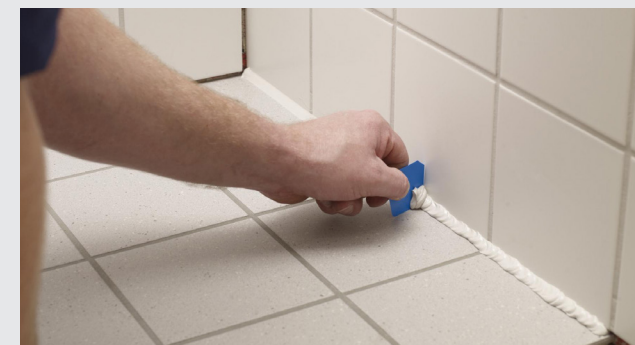
Överskjutande Alfix Silicon skrapas bort
