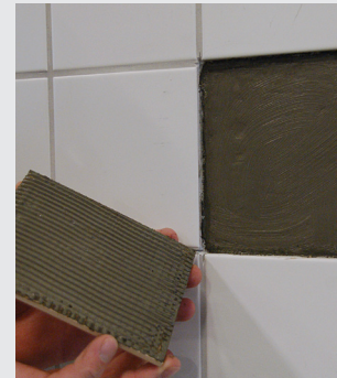
Tätningsmassan påförs underlaget och plattan monteras
