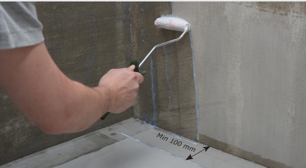
Reglering av underlagets sugförmåga
