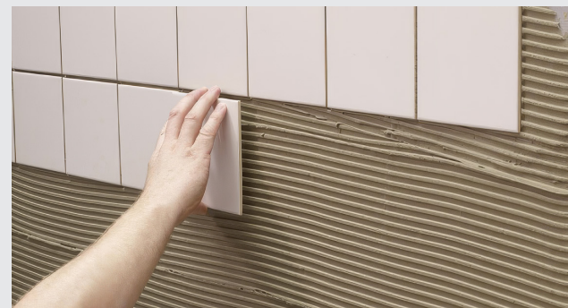
Montering av plattor på vägg
