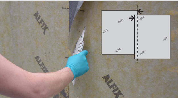
Montering av våd omlott vid skarv
