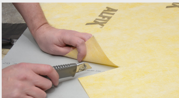
Skär snitt 100 mm i vägg/vägg vinkeln där våtrumsmattan svepas runt hörnet
