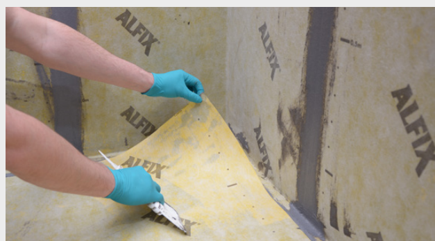
Montering av våtrumsmatta på golv
