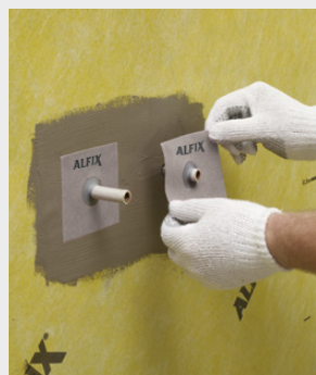
Montering av VT-Rörmanschetter
