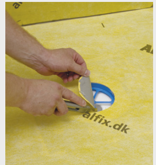
Alt. 2: Utskarvning med skärmall vid manschett
