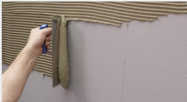
Påföring av fästmassa
