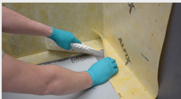
Montering av våtrumsmattan
