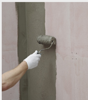
Påföring av tätningsmassa
