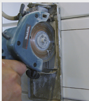
Skär ett spår längs plattkanterna. Avlägsna plattan försiktigt
