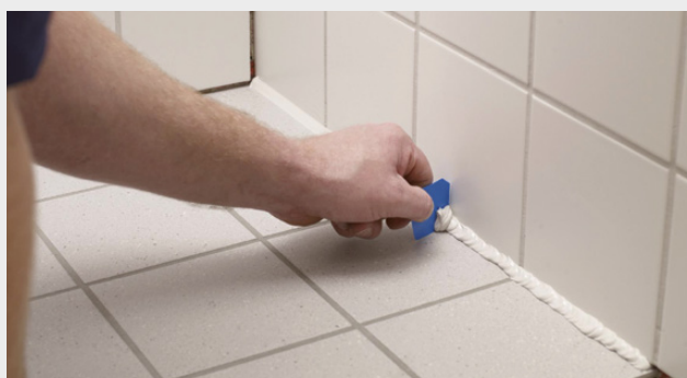
Överskjutande Alfix Silicon skrapas bort
