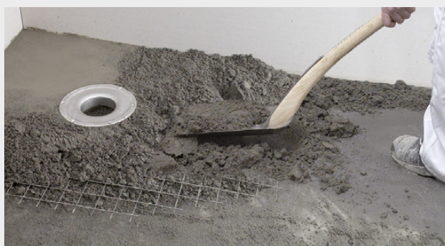
Golvlutning med cementbruk
