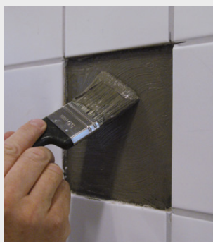
Tätningsmassan påförs underlaget och plattan monteras
