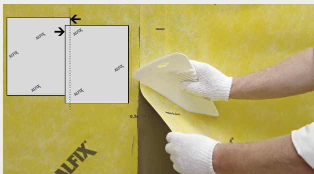
Montering av våd omlott vid skarv
