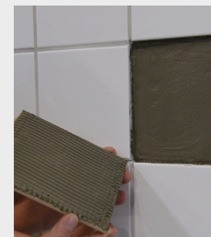
Tätningsmassan påförs underlaget och plattan monteras
