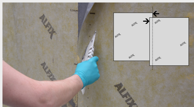
Montering av våd omlott vid skarv
