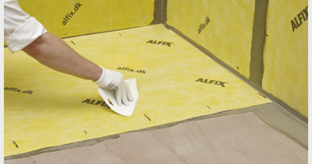
Montering av våd på golv
