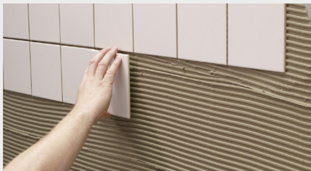
Montering av plattor på vägg
