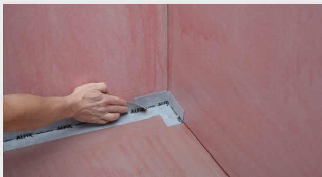
Montering av Seal-Strip, självhäftande
