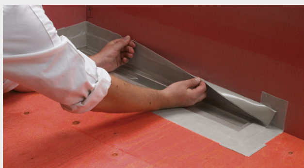
Montering av Seal-Strip vid väggnära golvbrunn
