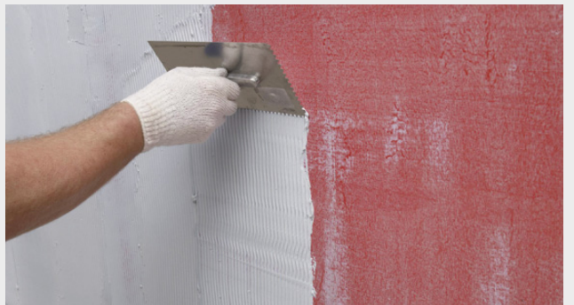
Påföring med tandspackel
