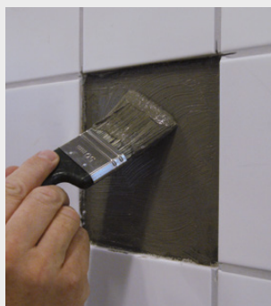
Tätningsmassan påförs underlaget och plattan monteras
