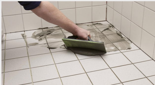
Påföring av fogmassa
