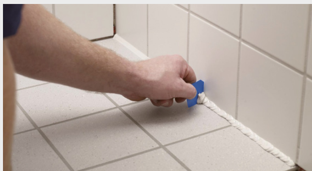
Överskjutande fogmassa skrapas bort
