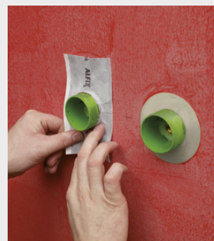
Montering av Seal-Strip, självhäftande
