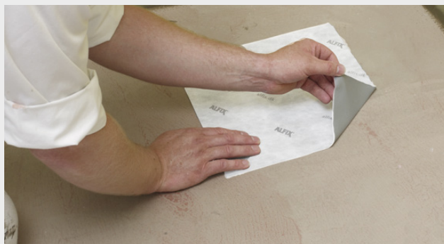
Skär ut hålet med kniv eller specialverktyg
