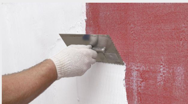
Påföring med tandspackel...
