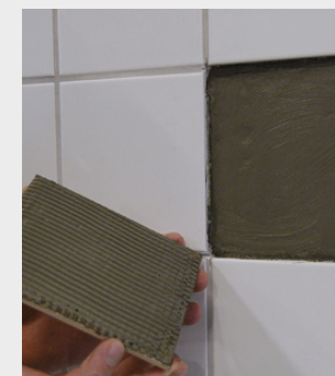
Tätningsmassan påförs underlaget och plattan monteras
