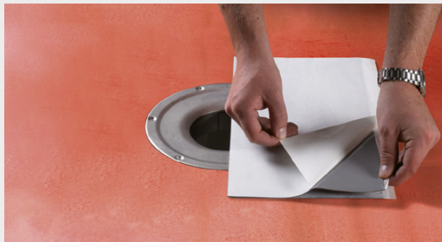
Montering av brunnsmanschett vid rund golvbrunn
