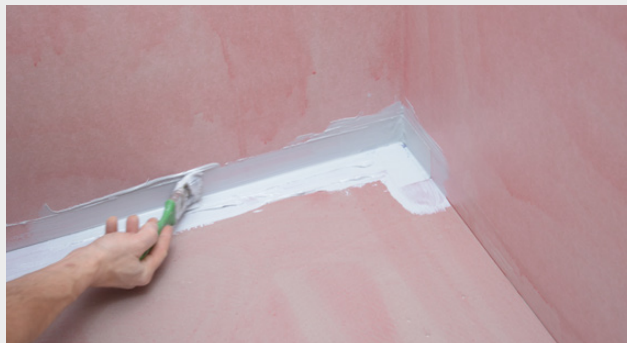
Montering av Armeringsremsa i tätningsmassa
