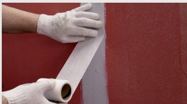
Skivskarvar förseglas med Armeringsremsa monterad i tätningssmassa
