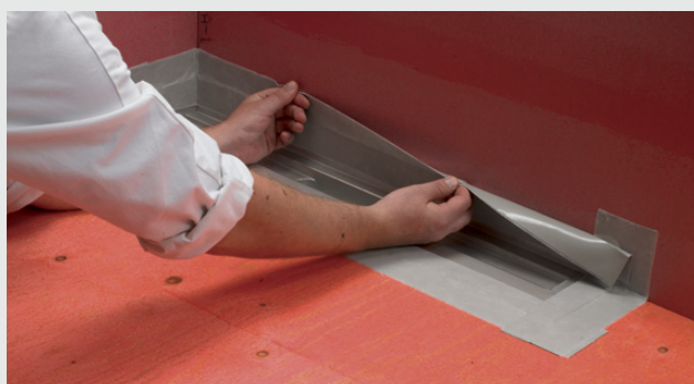
Montering av Seal-Strip vid väggnära golvbrunn
