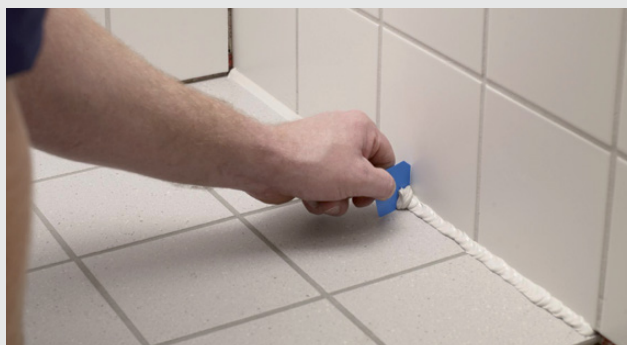
Överskjutande fogmassa skrapas bort
