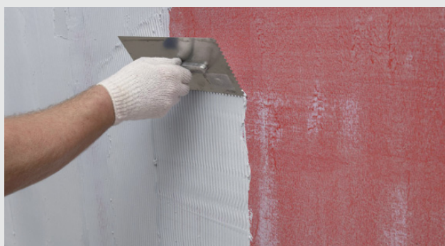
Påföring med tandspackel
