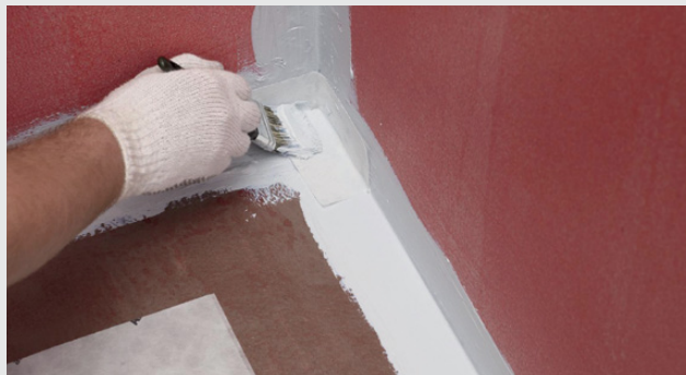
Montering av Armeringsremsa i tätningssmassa
