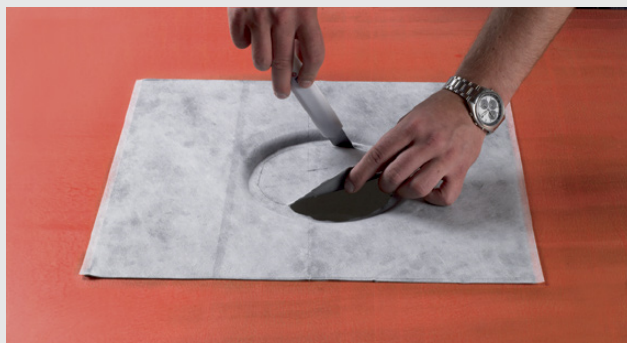
Skär ut hålet med kniv eller specialverktyg
