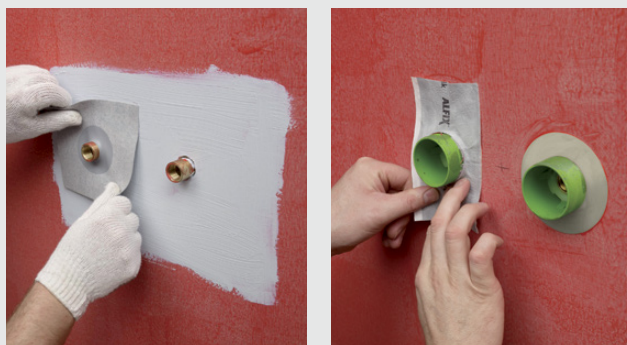
Montering av rörmanschett i tätningssmassa
