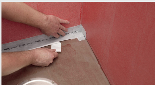
Montering av Seal-Strip, självhäftande
