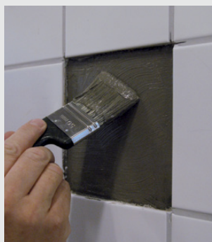
Tätningsmassan påförs underlaget och plattan monteras
