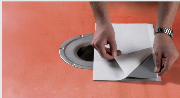
Montering av brunnsmanschett vid rund golvbrunn
