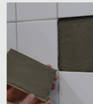
Tätningsmassan påförs underlaget och plattan monteras
